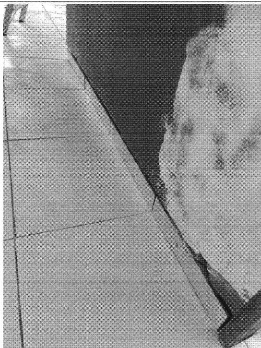
EMASSAMENTO DE PAREDES - UBS GATO
