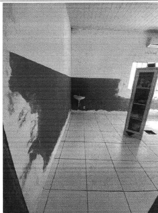
EXECUÇÃO DE REVESTIMENTO/ EMASSAMENTO DE PAREDES - UBS GATO
