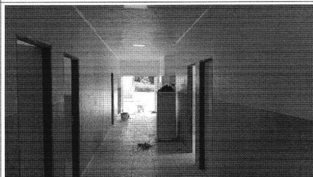
EXECUÇÃO DE PINTURA/ REVESTIMENTO CERAMICO - UBS GATO
