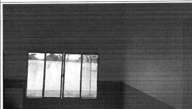
EXECUÇÃO DE PINTURA - UBS GATO
