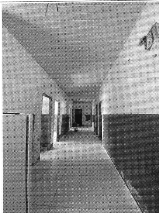
REVESTIMENTO CERAMICO - UBS GATO
