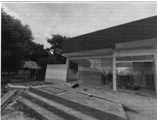
EXECUÇÃO DE PINTURA - UBS CAMPO AGRÍCOLA
