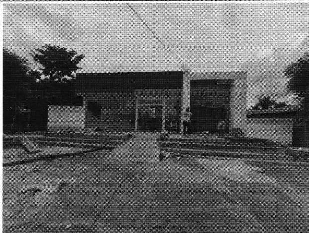
EXECUÇÃO DE PINTURA - UBS CAMPO AGRÍCOLA
